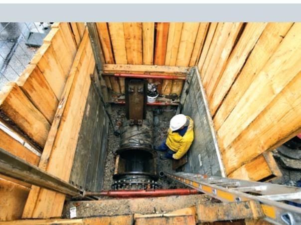
Sanierung über wenige Baugruben möglich: günstige Baukosten und kurze Bauzeiten zeichnen die Zementmörtelauskleidung aus.
