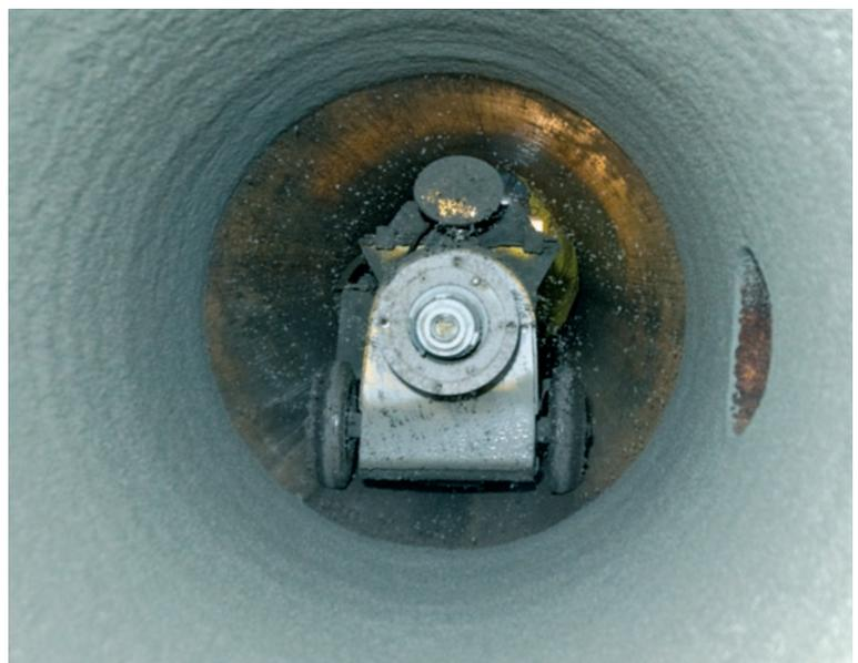
Mithilfe von Zugseilen und Winden wurden zunächst Kratzer zur Reinigung der Rohrleitungen von Baugrube zu Baugrube gezogen. Anschließend schleuderte eine Maschine mit rotierenden Köpfen den Mörtel an die Rohrwand.
