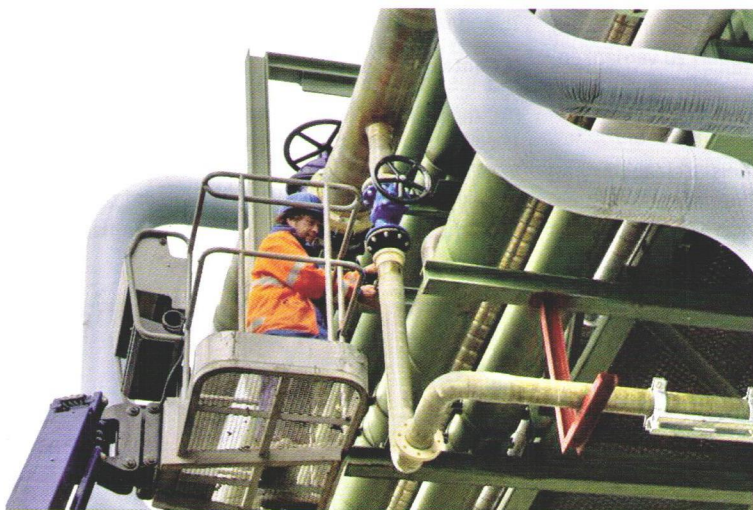
Bild 1: Installation der neuen Brunnenwasserleitung
