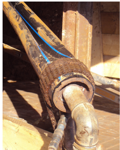
Verschlussmodul am Rohrende: Unter Dampf und Druck „erinnert“ sich das Rohr an seine kreisrunde Form (Memory-Effekt) und formt sich zurück.
