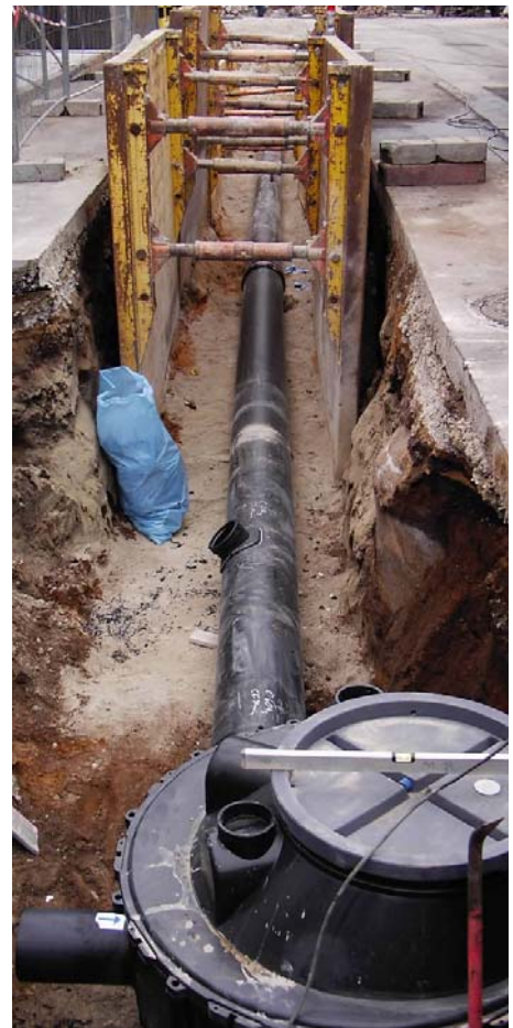
Neue Leitungen aus PE-HD garantieren ein sicheres Abfließen des Produktionsabwassers.
