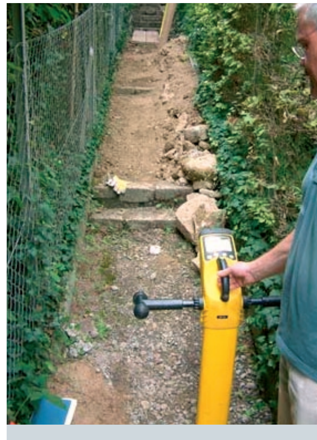
Zielgenaue Pilotbohrung durch einen Sender in der Spüllanze.
