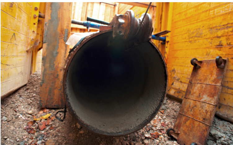
Selbst alte und schadhafte Rohrleitungen werden durch die Zementmörtelauskleidung wieder wie neu.
