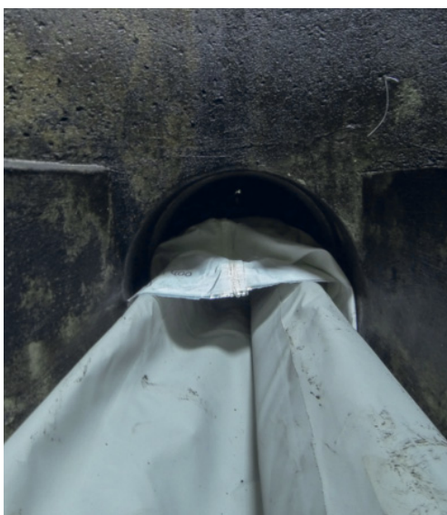
Der eingezogene Liner vor dem Aufstellen mittels Druckluft.
