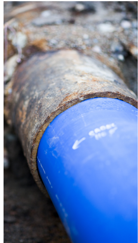
Der Memory-Effekt sorgt dafür, dass sich der Liner nahtlos an das Altrrohr anlegt.
