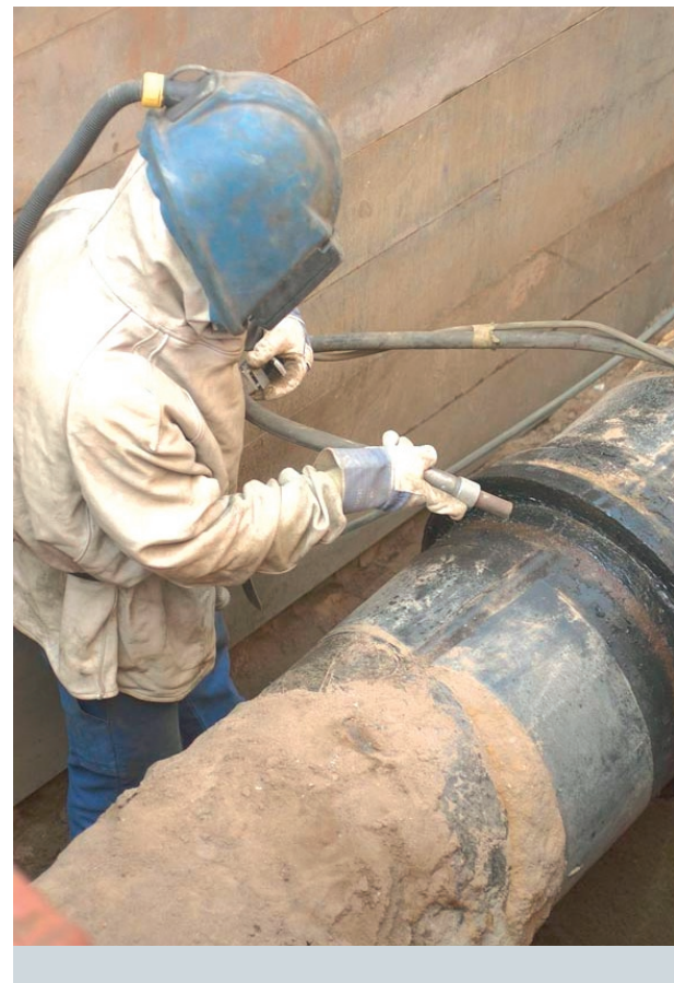
Vor Beginn der eigentlichen Sanierungsarbeiten mussten die undichten Muffen gereinigt werden.
